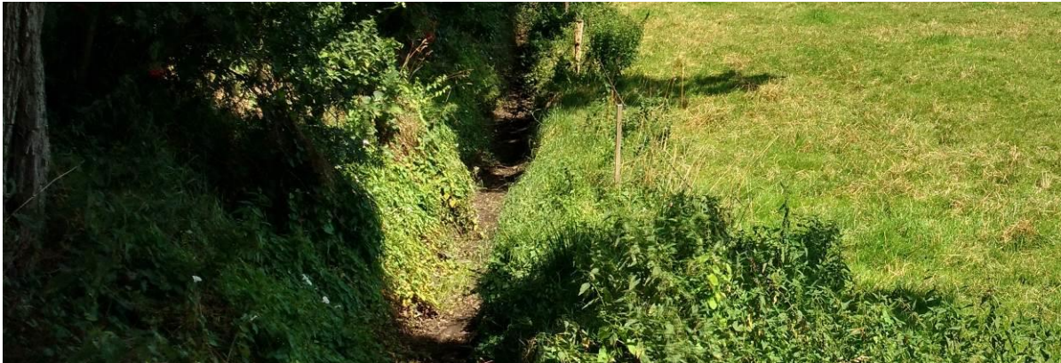
Graben im Bereich Friedewaldstraße / Blickrichtung Ost
