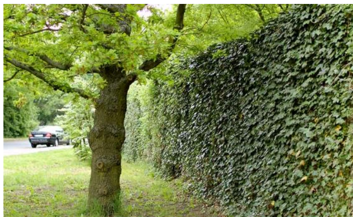
Eine begrünte Lärmschutzwand / Quelle: k-nord.com
